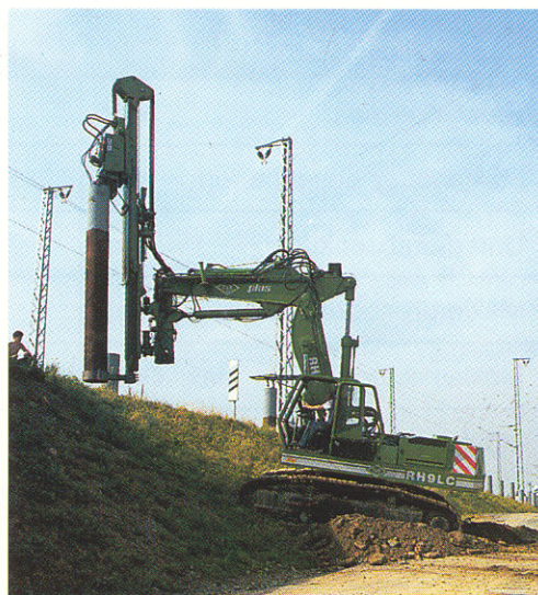
ABI RE 6000-S mit Vibrohammer VRZ 300 GL für Sonderreichweiten
