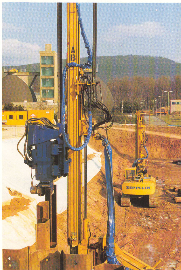
ABI Mobilram RE 12/14300 mit Vibrohammer VRZ 600 GL
